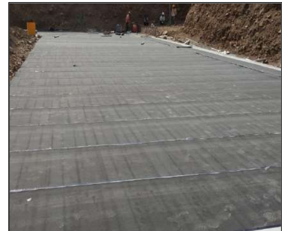
TPO/HDPE Membrane
