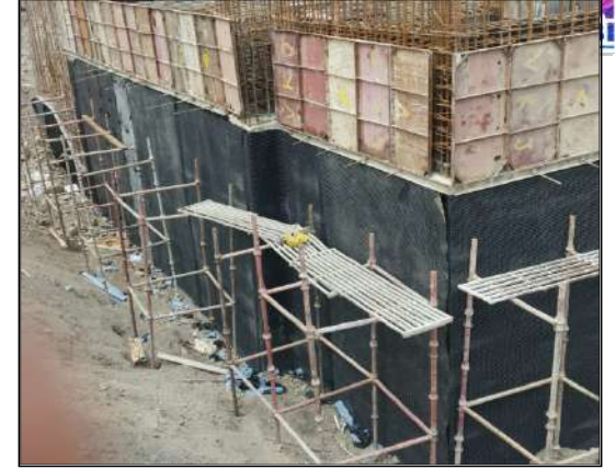
TPO/HDPE Membrane
